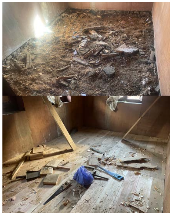
चित्र नं.३ : कर्मचारी आवास भवन मर्मत, नाम्चेबजार
