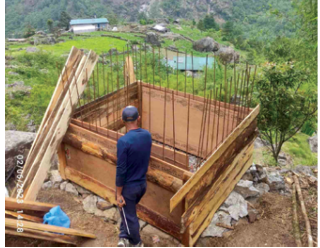
चित्र नं. २८: खानेपानी ट्याङ्की निर्माण, नाक्चुङ
