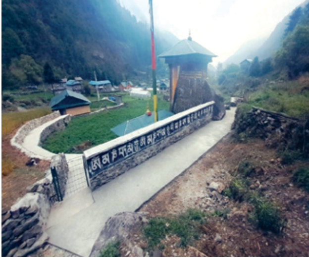
चित्र नं. २७: बाटो निर्माण, घाट
